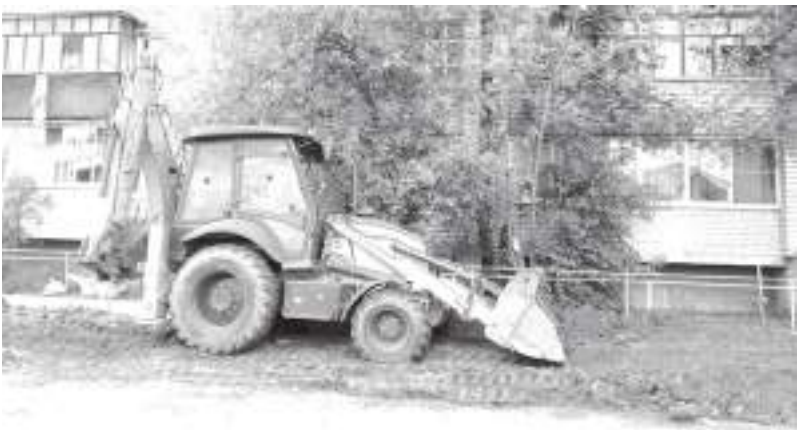
На улице Русинова в Ермолине капитально отремонтированы сети отопления и ГВС
