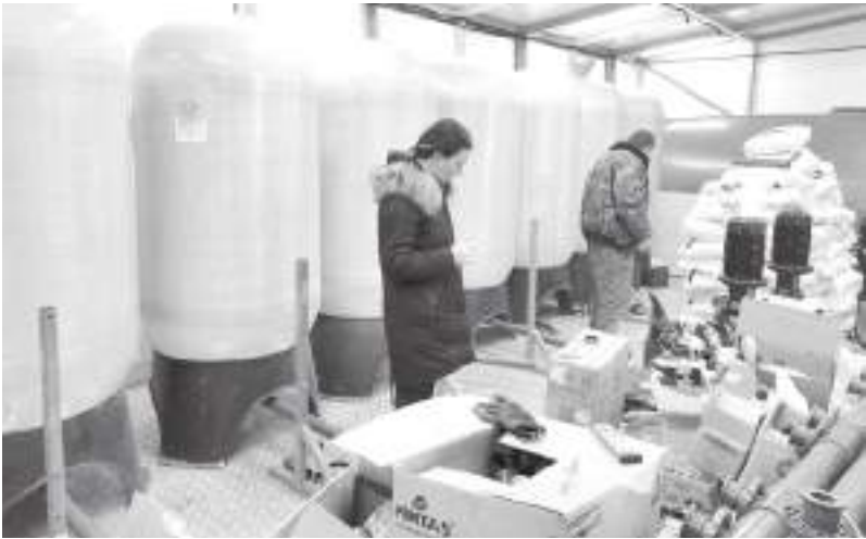
В Боровске построили станцию водоподготовки
