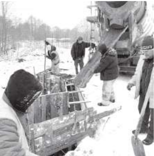
Устройство поперечного дренажа дороги в деревне Городня выполнили при поддержке Фонда
