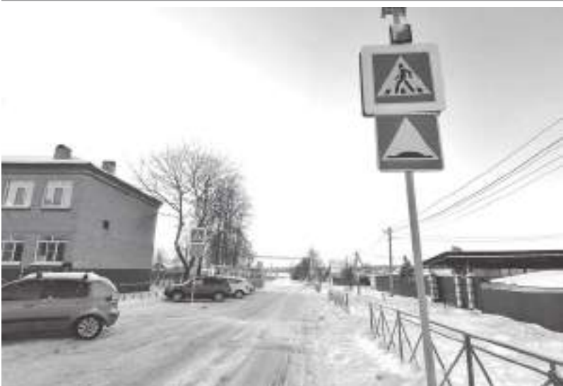
В Кривском отремонтировали тротуар, установили знаки и ограждение
