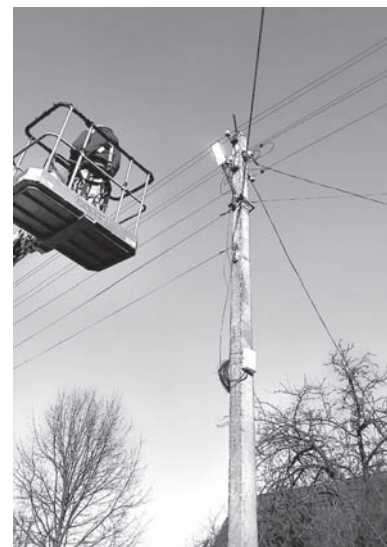
Сотрудники электросетей меняют лампу на улице Жукова
