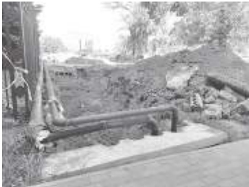
В Балабанове продолжают прятать теплотрассу под землю. Сейчас работы проводят в районе «Россельхозбанка»
