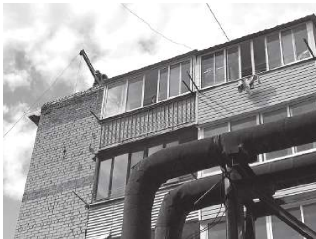
На плоских крышах вместе с покрытием также восстанавливается стяжка и система внутреннего водостока
