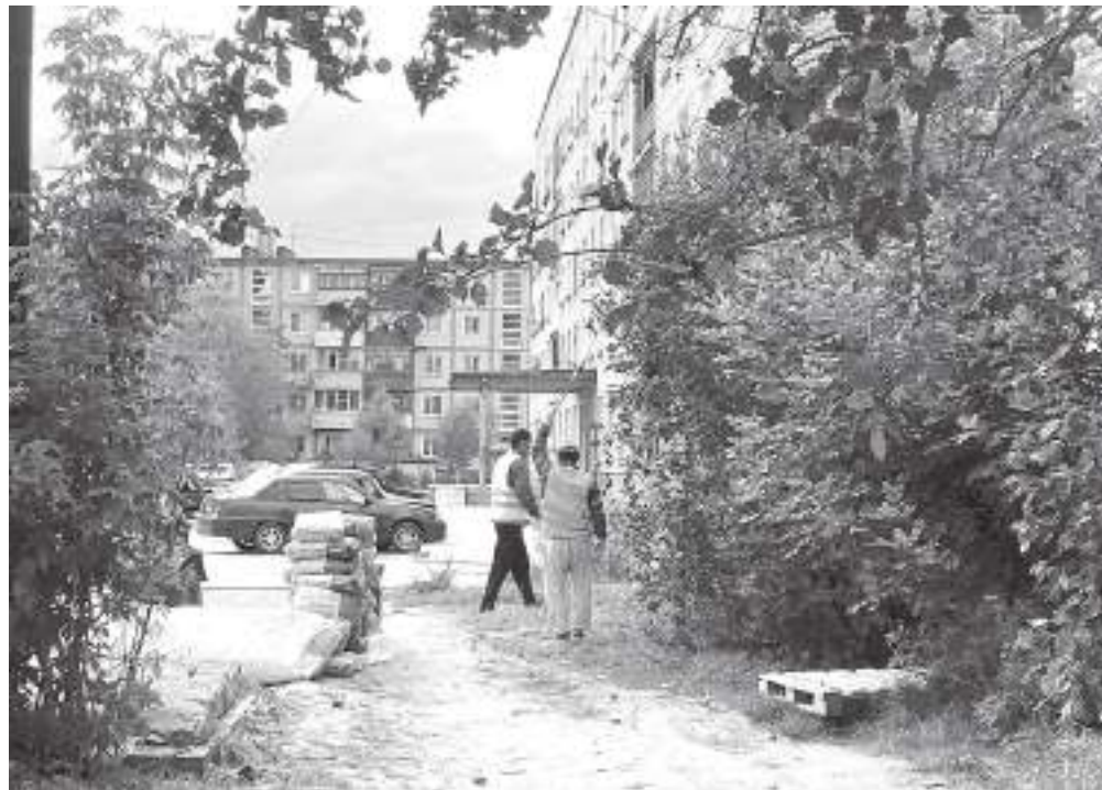
Будьте осторожны в зоне проведения строительных работ, сейчас на домах как раз проходит демонтаж старой кровли
