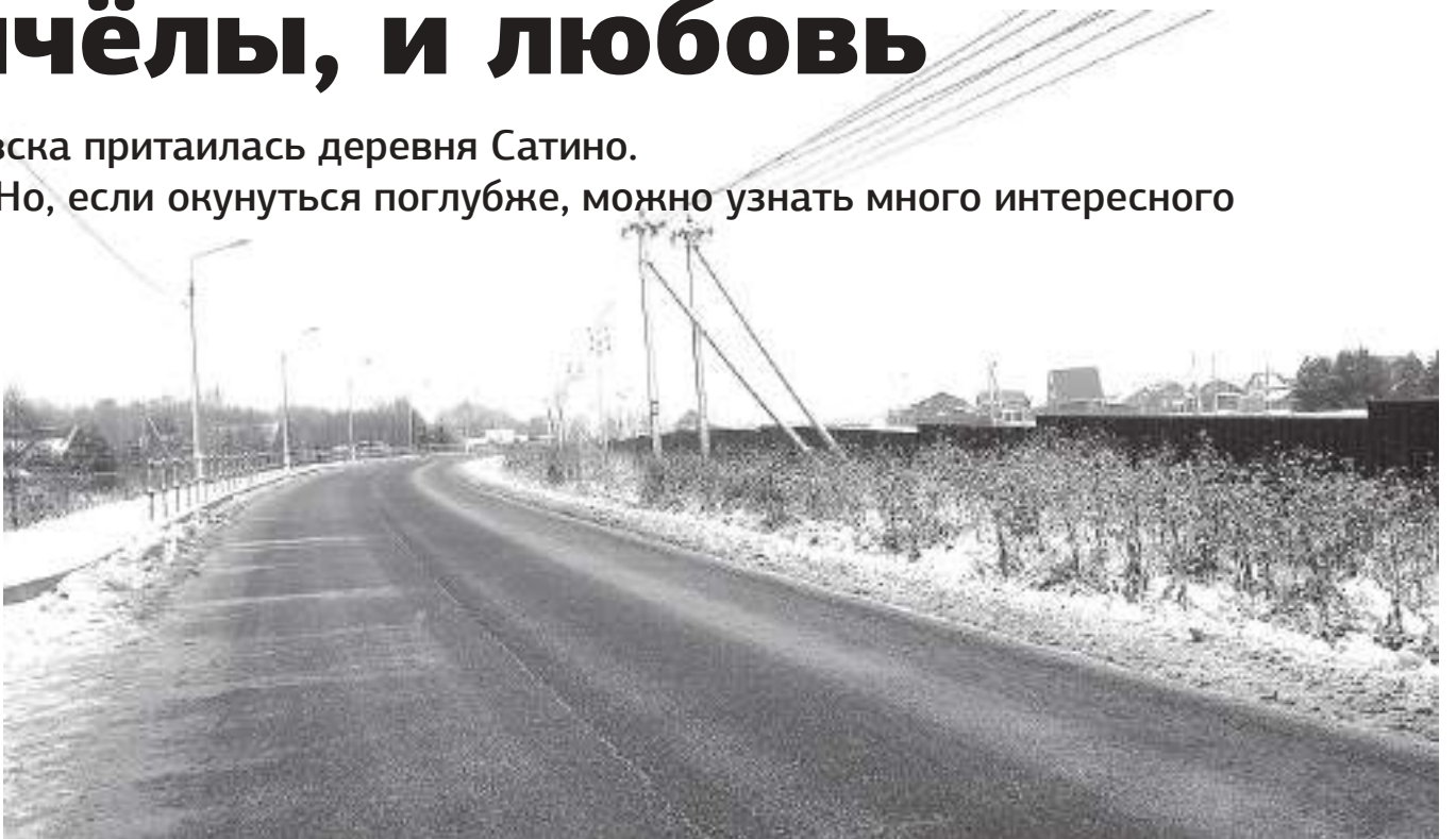
На въезде в деревню смонтировано освещение
