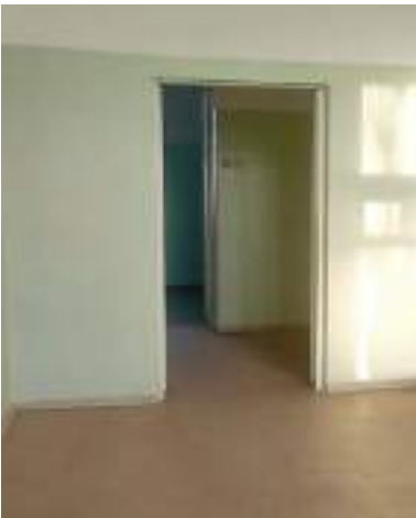
Вложений в ремонт палат на втором этаже не требуется, необходимо лишь оборудование
