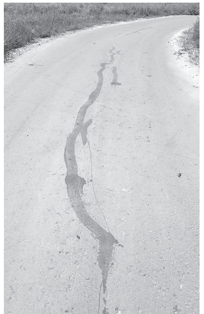
А так выглядит ремонт трещин, оставшихся на дорожном полотне после зимы. Фото улица Текстильная
