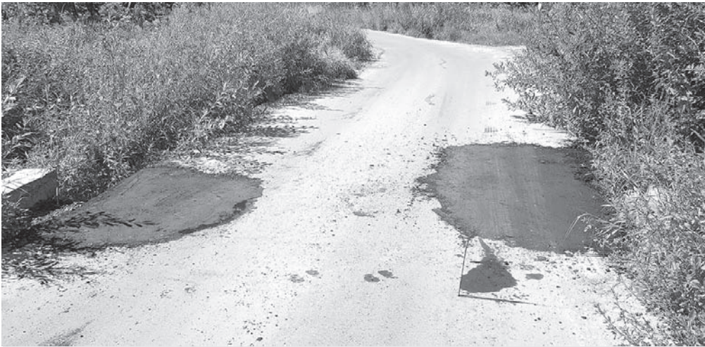
Судя по разметке, сначала подрядчик собирался сделать срез геометрической формы, но потом что-то пошло не так. Фото улица Текстильная
