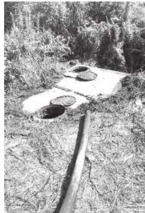
Сейчас коллектор рядом с Островского, 111 больше не выплёскивает нечистоты
