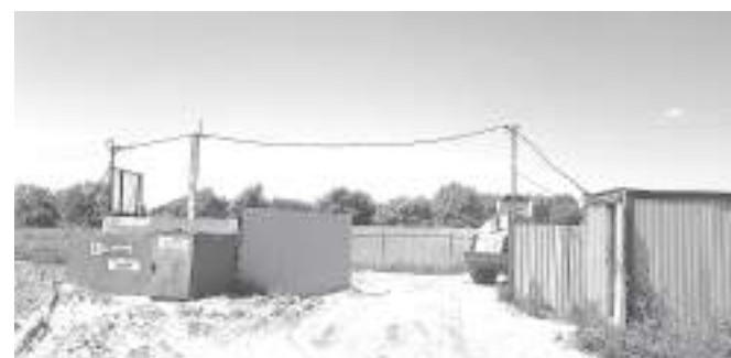
Пока на объекте расположились только «городок» строителей и стоянка для техники
