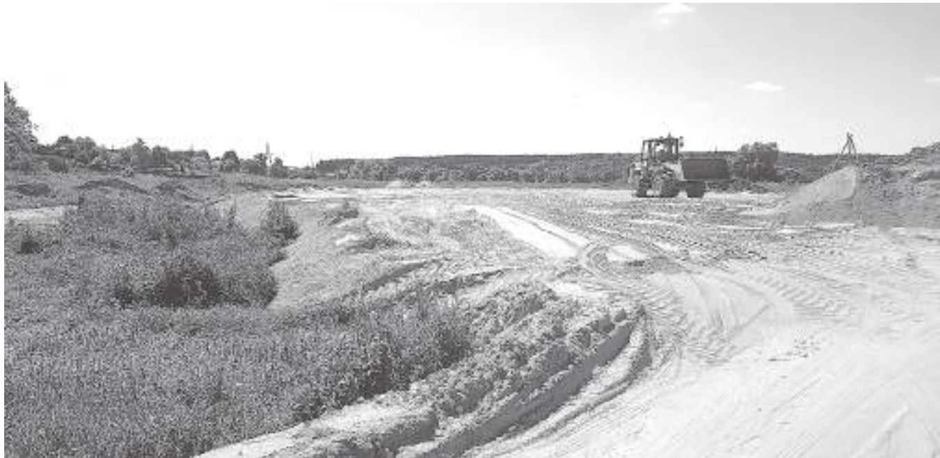
Сейчас на участке ведутся подготовительные строительные работы
