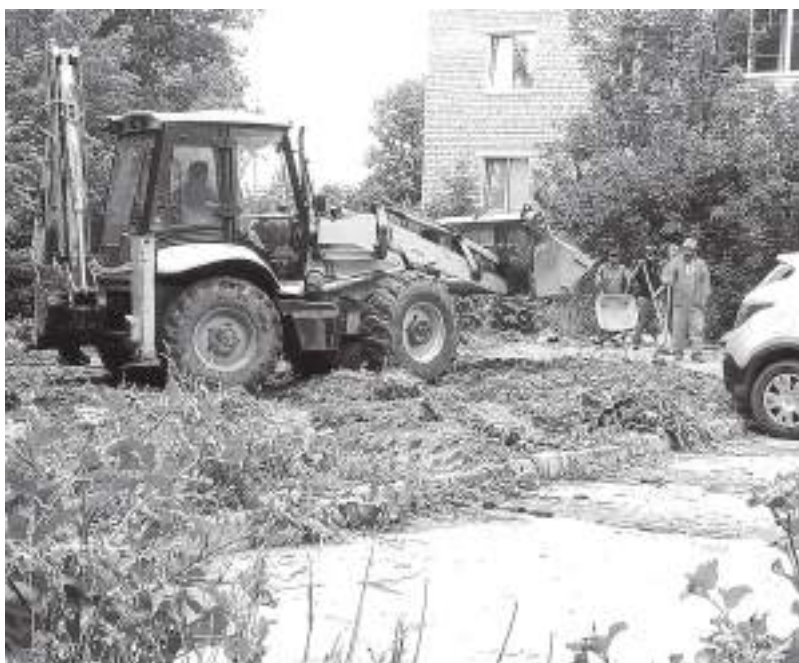
На стройплощадке работала техника
