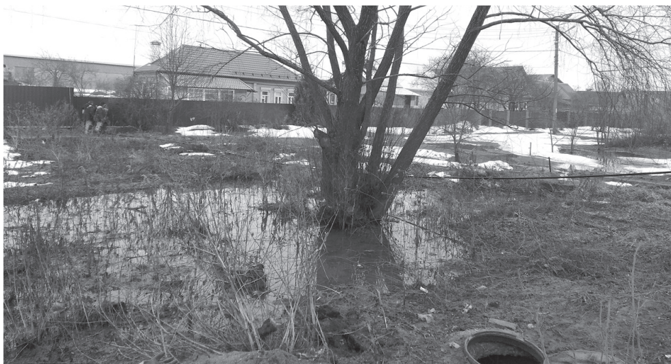
Из-за забитого люка канализационные стоки затопила месяц назад всю округу
