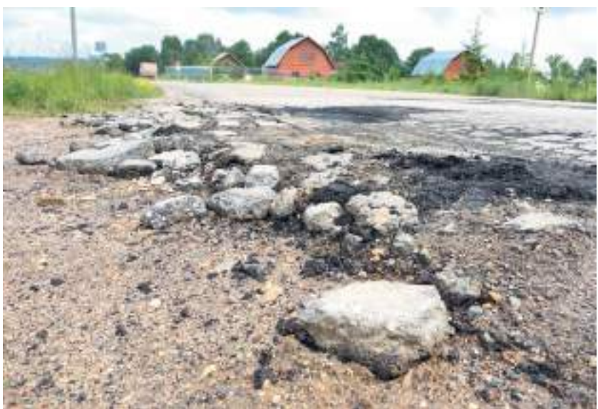
Трасса из Совьяков в Сатино только успела отслужить пятилетний гарантийный срок, как пошла первыми выбоинами. Одна из них акkurat над газопроводом, что проходит под дорогой
