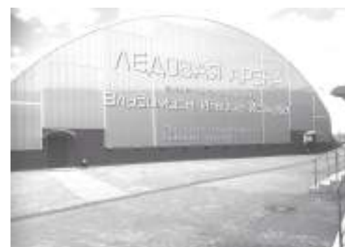
В Кирове ледовая арена выполнена в виде купольной конструкции
