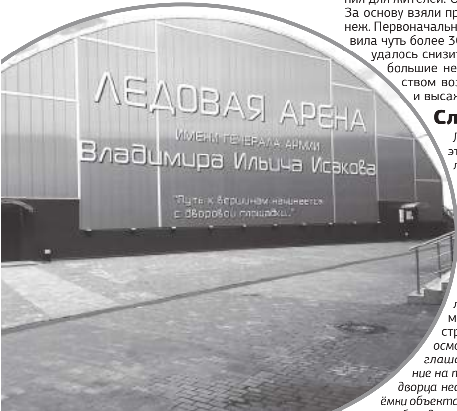
В Кирове ледовая арена выполнена в виде купольной конструкции
