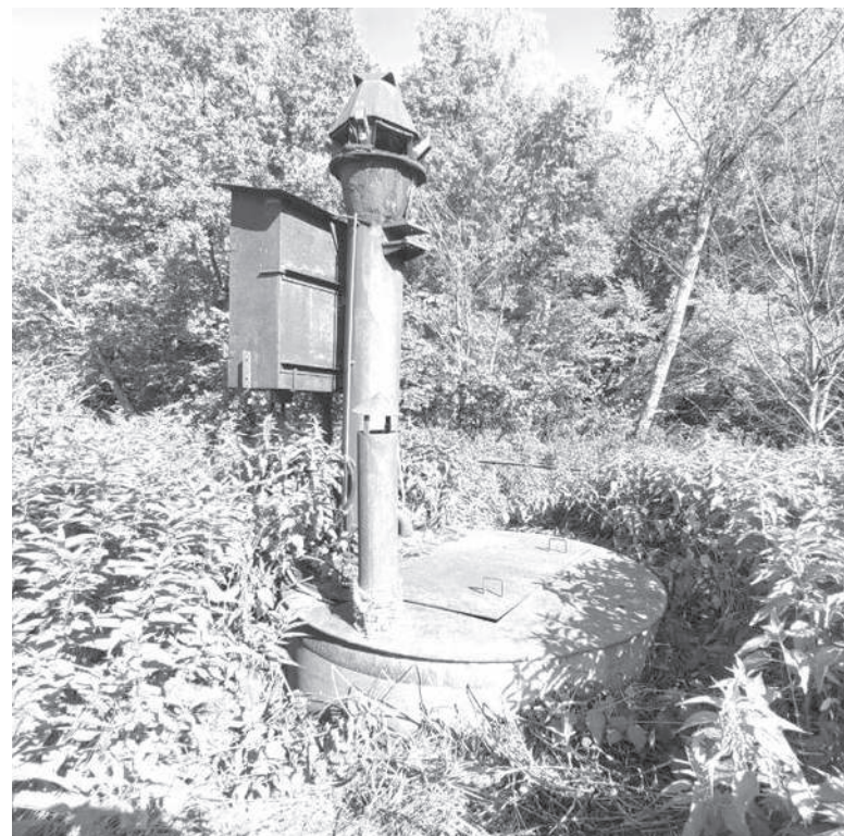
Нечистоты стекают по улице, а дальше в реку Страдаловка
