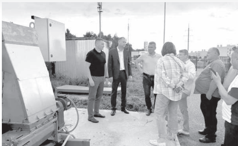
Шаг к чистой воде - осмотр нового оборудования на канализационной насосной станции в Калуге
