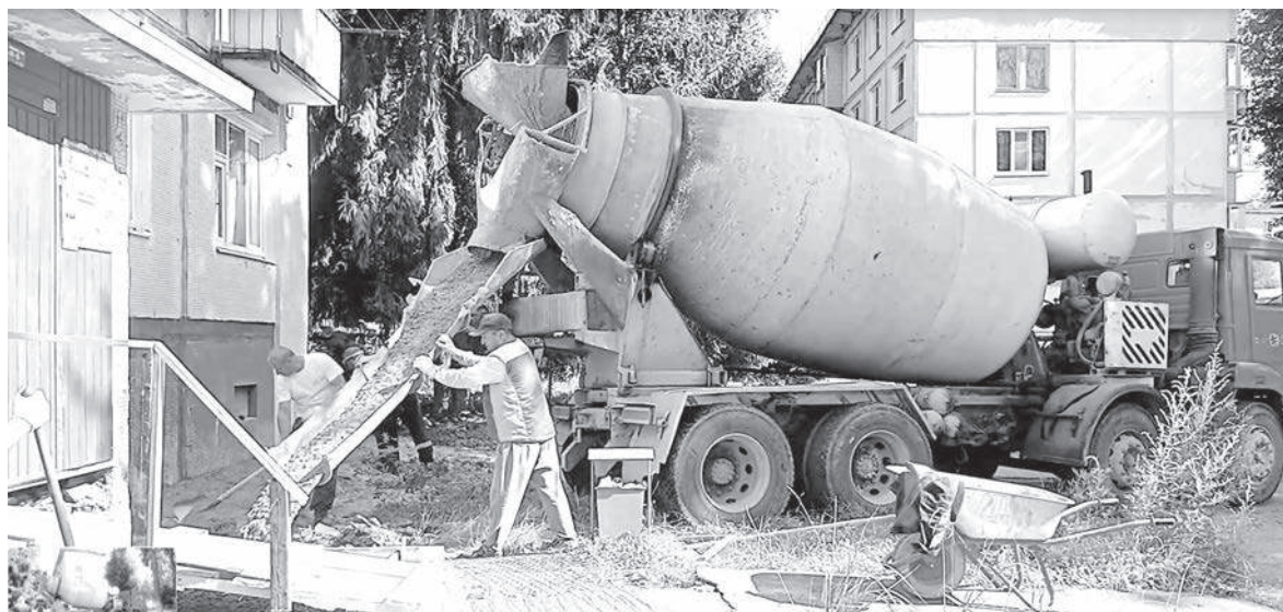
Ремонт отмостки дома №93 по ул.Дзержинского
