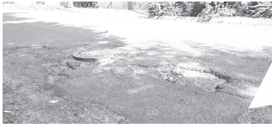
На Мира перед укладкой асфальта приведут в порядок все колодцы
