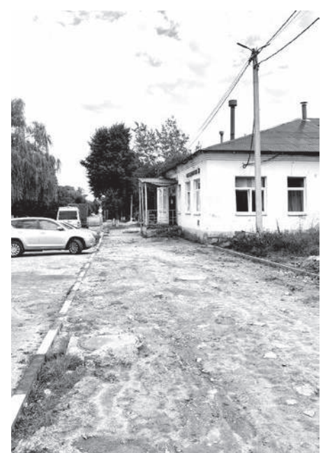
Тротуар на Лесной стал долгостроем
