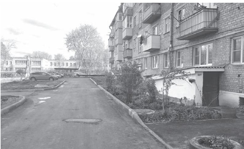
Таким сейчас видят свой двор жители Мичурина, 1, но впереди ещё много работы – монтаж лавочек, урн и освещения
