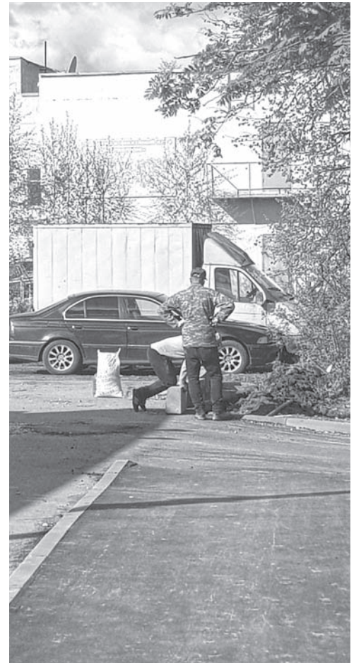
Строители устанавливают бордюрный камень рядом с Мичурина, 1а
