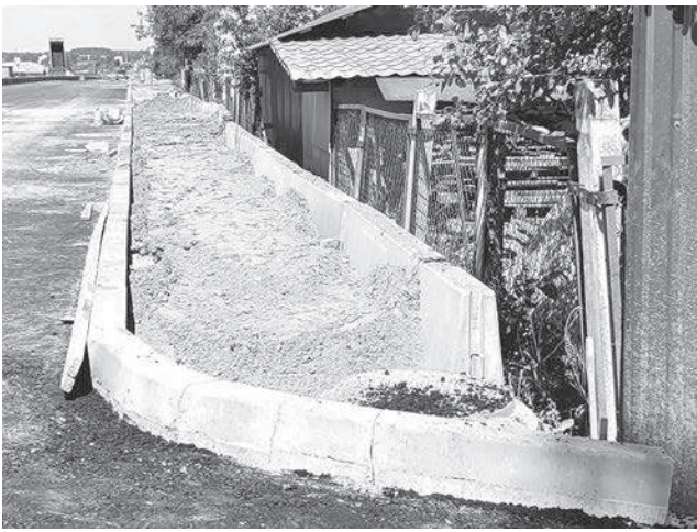
Бетонные блоки защитят от случайностей
