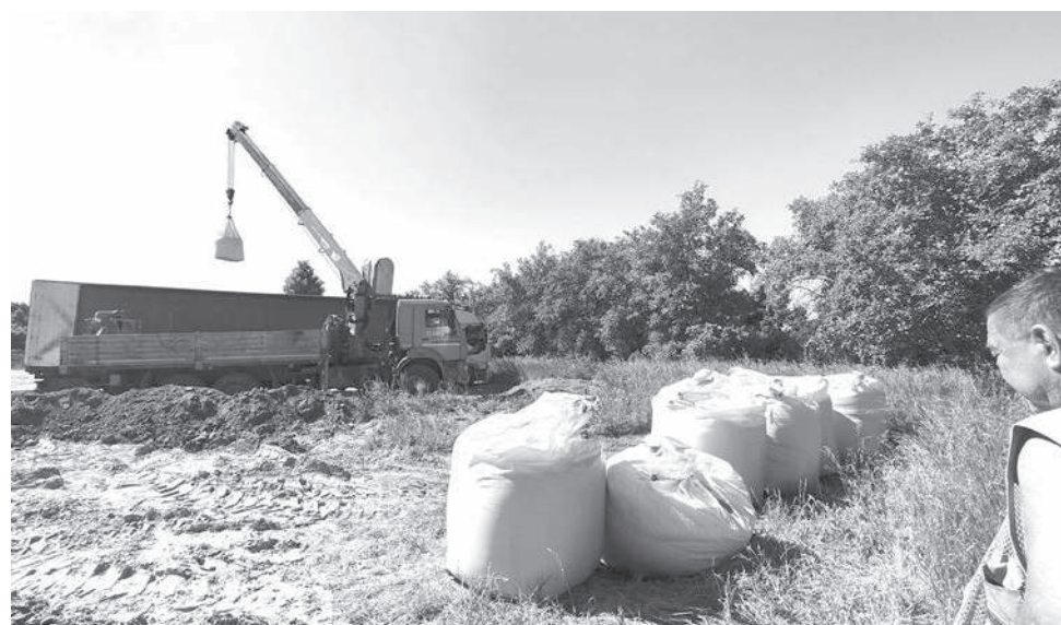
На объект завозятся необходимые материалы для засыпки слоёв
