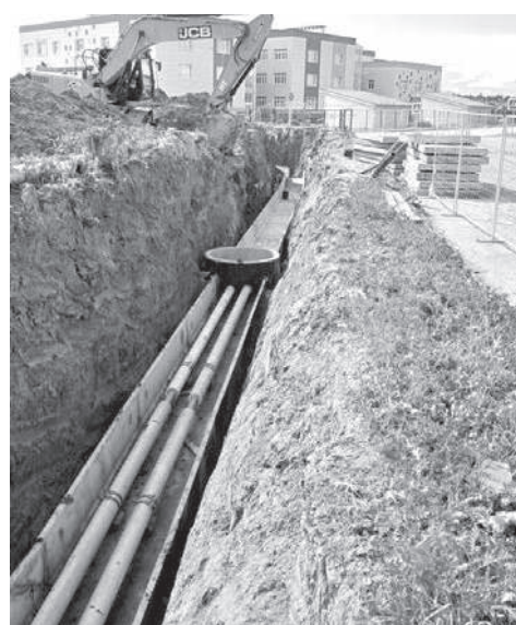
На улице Пионера-героя Вани Андрианова трубы убирают в железобетонные лотки
