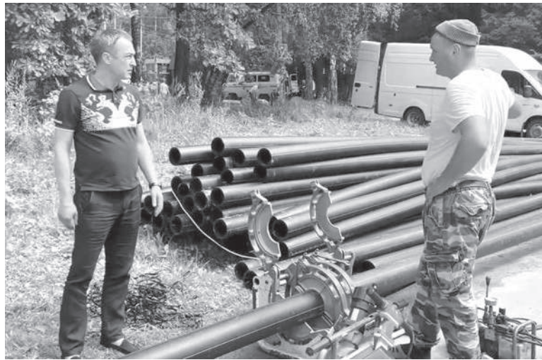
В 2025 году на улице Дзержинского был переложен трубопровод от дома № 84 до 91-го
