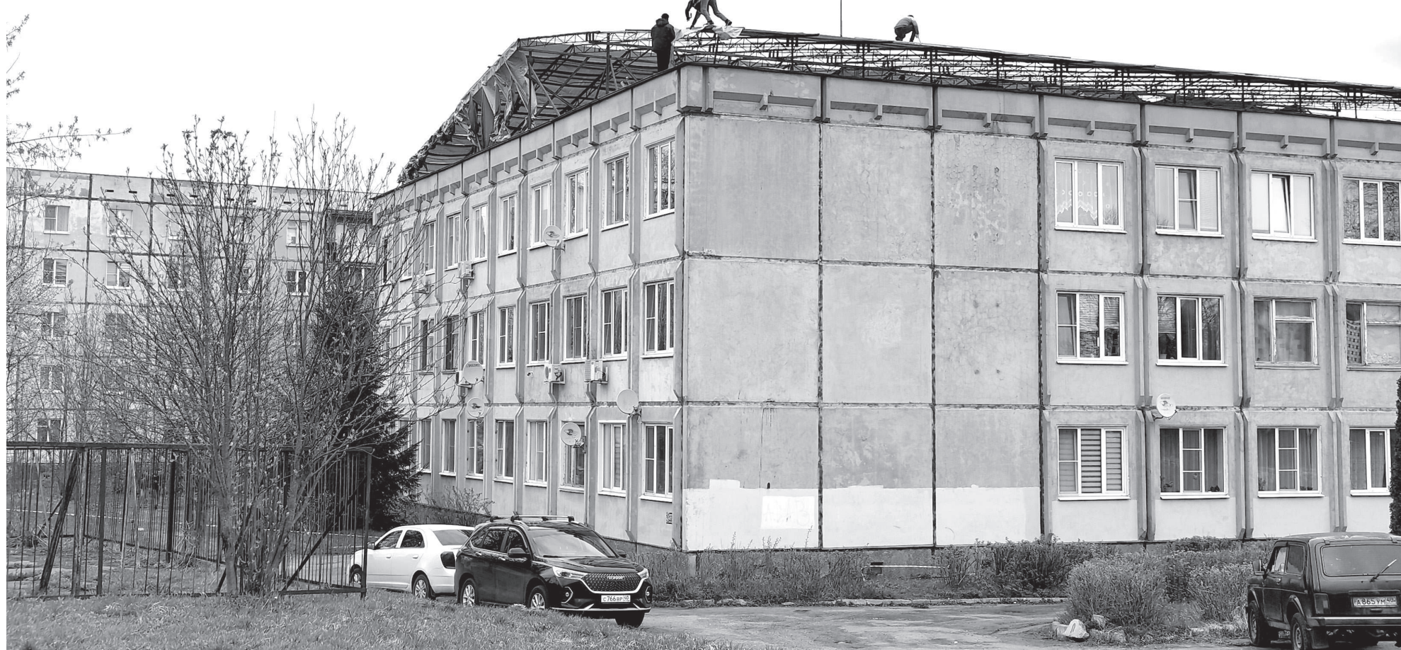
Сооружение защитного шатра над кровлей
