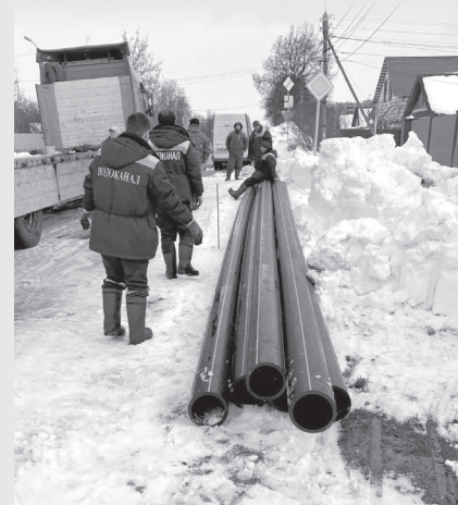
Ремонтная бригада Водоканала проложила новый трубопровод канализации протяжённостью 56 метров
