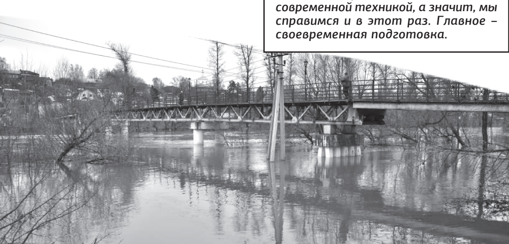
Многие пешеходные подвесные мосты необходимо закрепить, в противном случае их смоем быстрым течением
